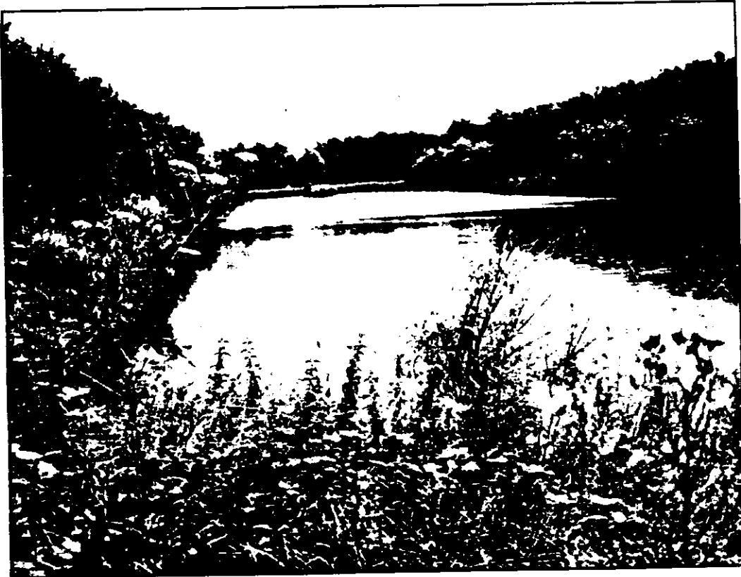
Stommel: Versickerungsbecken an der K 14 für den Büsdorfer-, Ingendorfer- und Stommelner Bach und den Fliestedener Graben. Fassungsvermögen 25.000 Kubikmeter.
