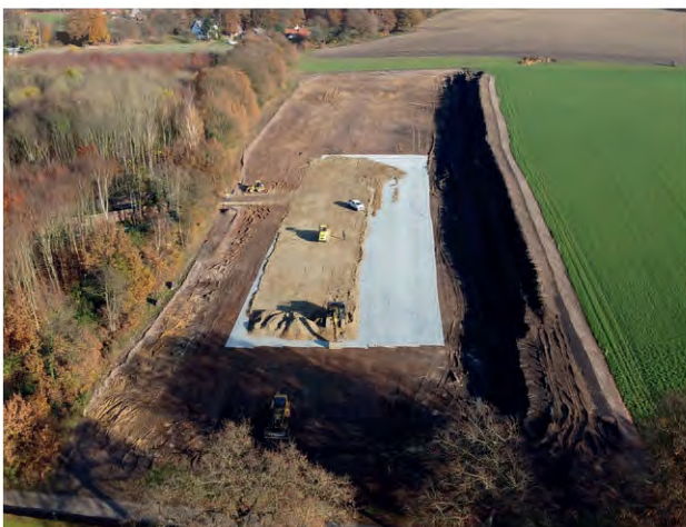
Bild 6.6 – Vorbereitungsphase am Auslaufbauwerk
