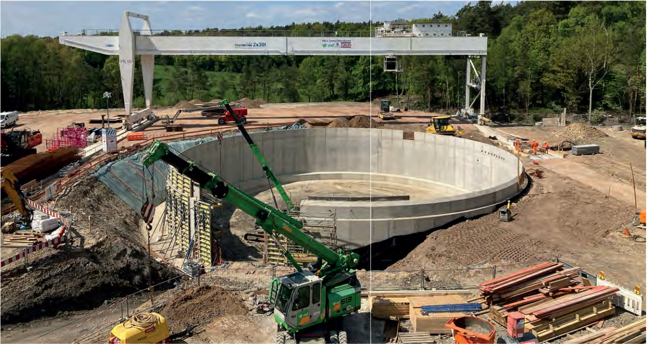
Bild 6.10 – Bauphase am Mittelschacht (Quelle: RAG AG)
