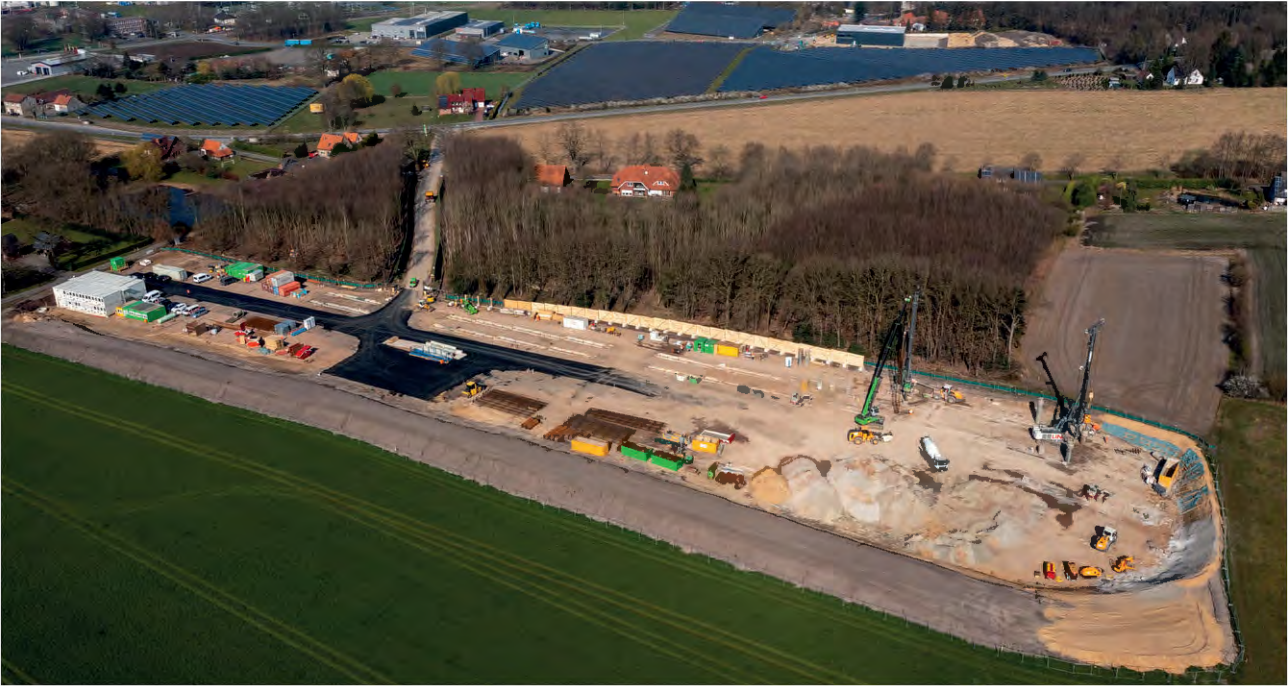
Bild 6.9 – Bauphase am Auslaufbauwerk (Quelle RAG AG)
