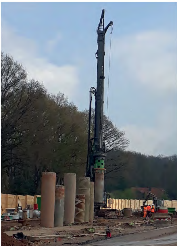
Bild 6.8 – Drehbohrgerät (Quelle: BR Arnsberg)
