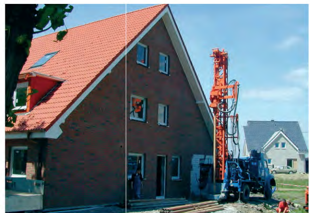
Bild 2.2 – Geothermiebohrung (Quelle: Bezirksregierung Arnsberg)
