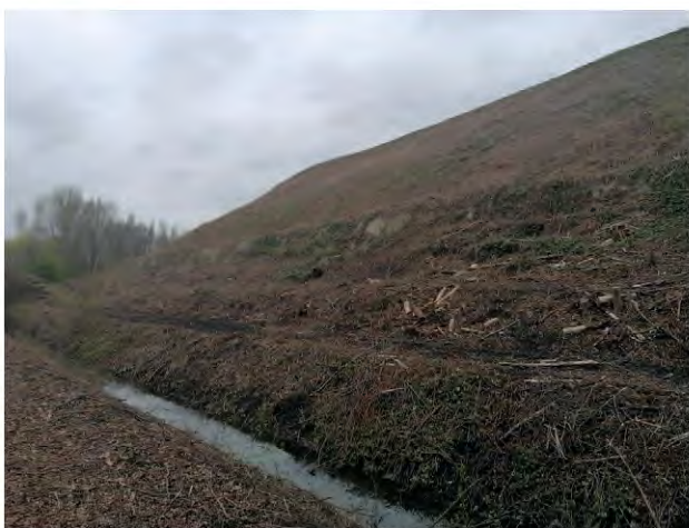
Bild 9.10 – Zu verrohrender Mühlenbach und freigeschnittene Böschung
