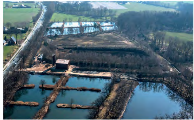
Bild 5.2 – Grubenwasserbehandlungsanlage Püsselbüren im Bau (Quelle: RAG AG)
