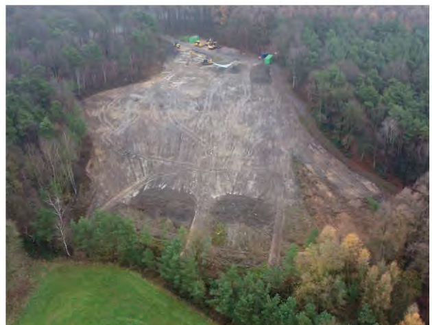
Bild 6.7 – Vorbereitungsphase am Mittelschacht
