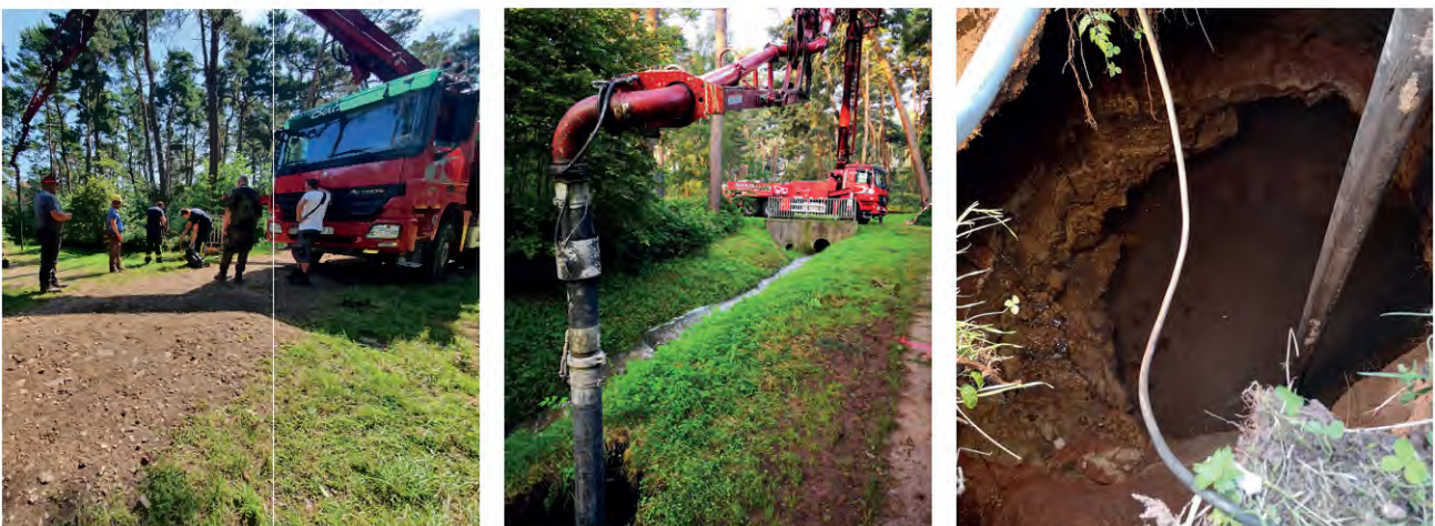
Bilder 10.9, 10.10 und 10.11 – Sicherungsarbeiten im Nahbereich eines Bachlaufes
