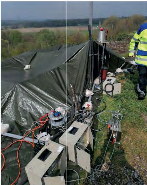
Bild 9.13 – Anordnung der Emissions-Messstelle mit Speichertechnik
