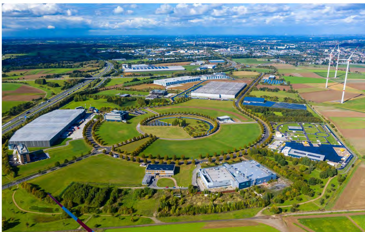
Abbildung 3: Luftaufnahme Avantis GOB N.V. (Bildnachweis: Avantis)
