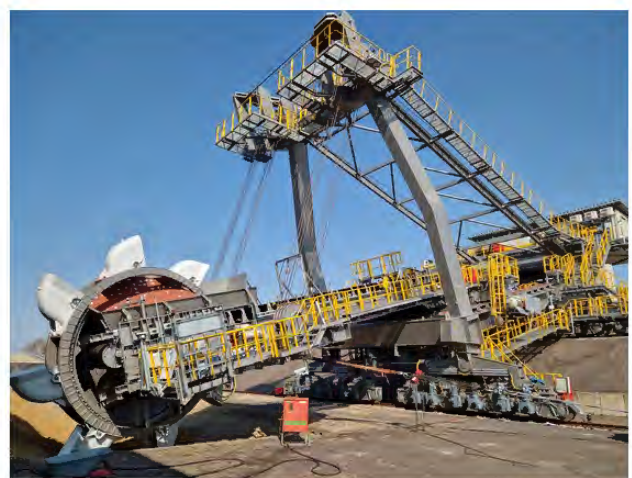
Bild 5.1 – Aufnahmegerät 820 kurz vor der Inbetriebnahme (Quelle: Bezirksregierung Arnsberg)
