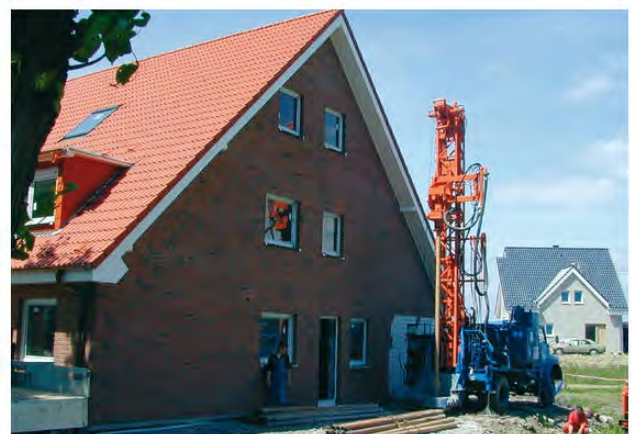
Bild 2.2 – Geothermiebohrung (Quelle: Bezirksregierung Arnsberg)
