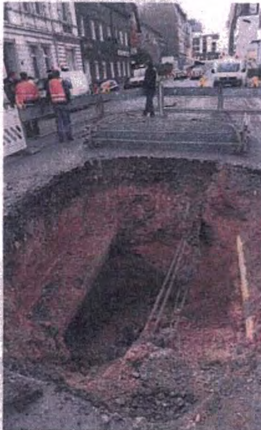
Etwa fünfseinhalb Meter ist das Loch in der Gasstraße an seiner tiefsten Stelle. Am Freitag hatten es die Entsorgungsbetriebe komplett freigelegt und die dort liegenden Leitungen überprüft. Jetzt ist es abgedeckt. FOTO: KEMPKER
