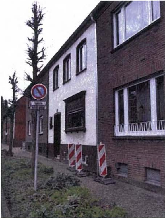
Bild 19: Absackung im Gehweg [Foto: Stadt Emmerich]
