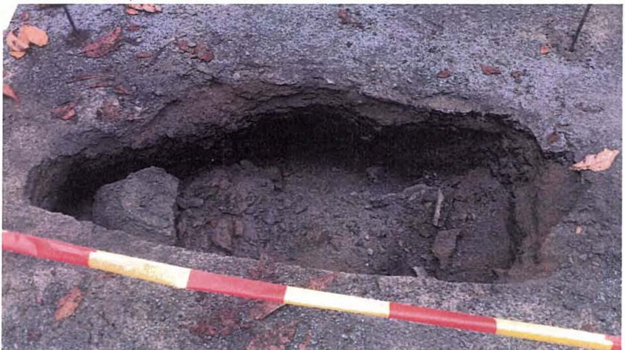
Bild 67: Detailansicht zu Bild 66 [Foto: Lobbe Entsorgung West GmbH & Co KG]
