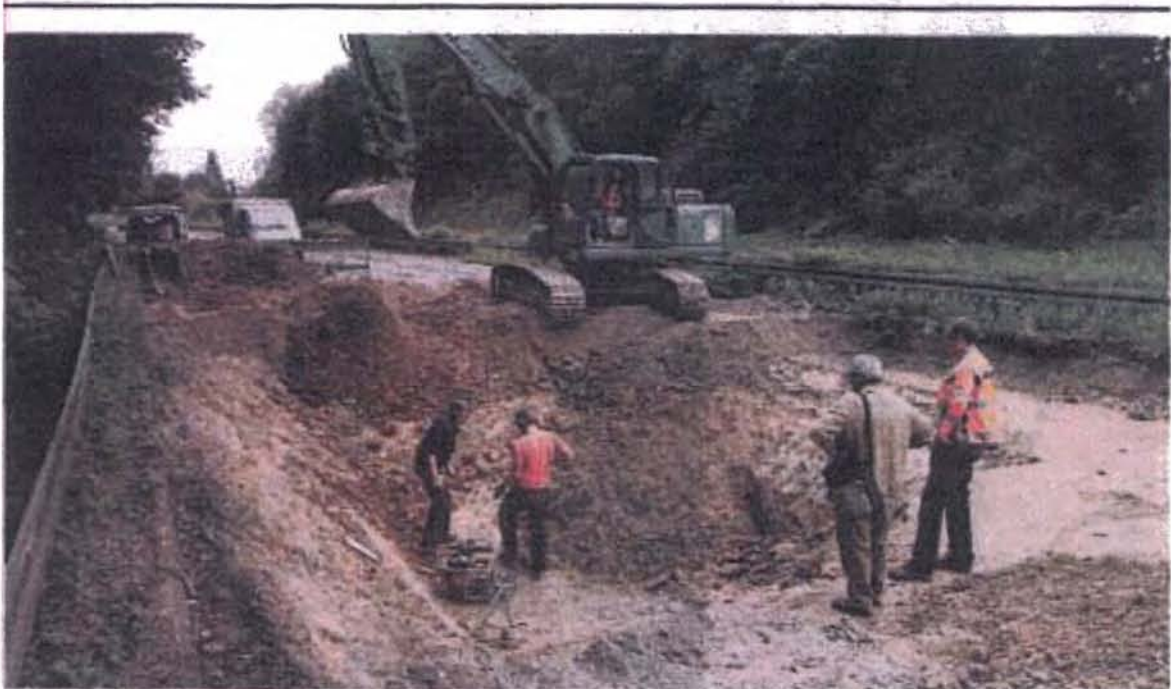
Über die beiden Fahrspuren Richtung Solingen rollen eigentlich täglich rund 22 000 Fahrzeuge. Gestern standen im inzwischen 20 Meter langen, 13 Meter breiten und über fünf Meter tiefen Krater Mitarbeiter eines Kölner Gutachterbüros und führten Sondierungsbohrungen durch. Fotos: Christian Beier
