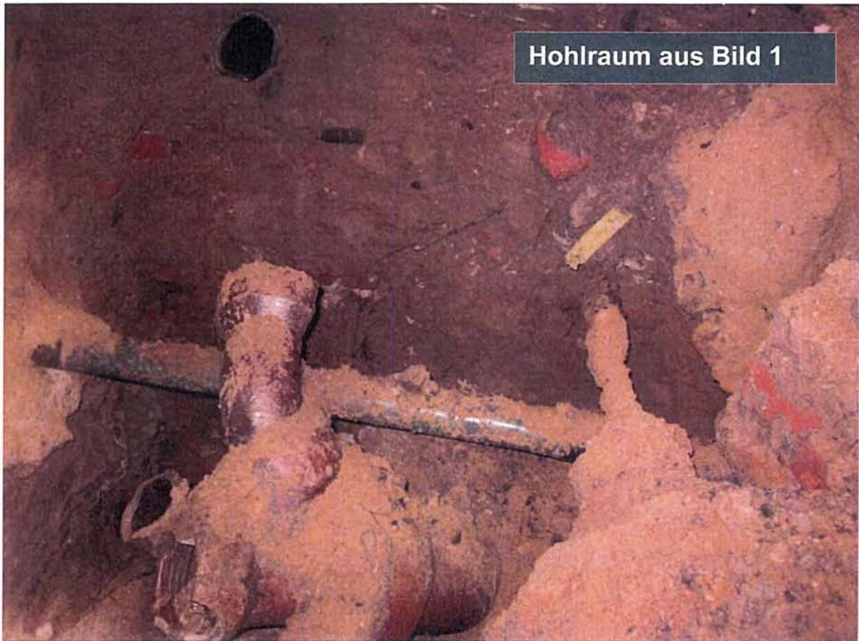
Bild 2: Hohlraum durch defekte Abwasserleitung - Detailansicht zu Bild 1 [Foto: Stadt Alsdorf]
