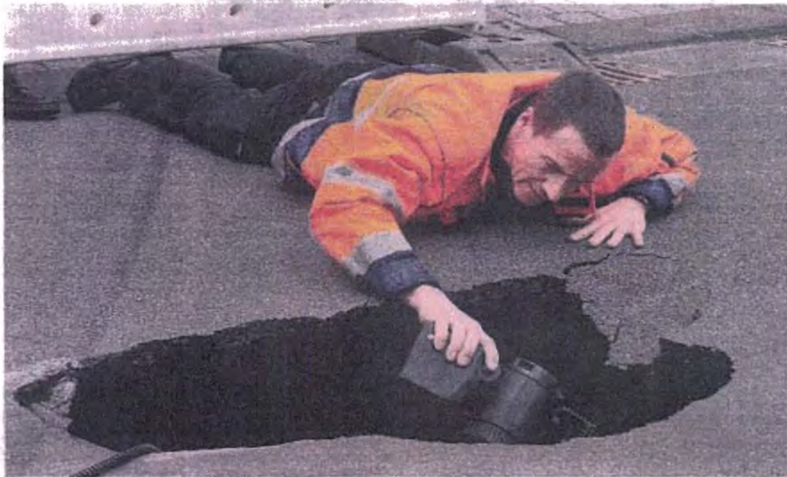
Marco Brings von den Entsorgungsbetrieben robte sich vorsichtig an das Loch heran. Mit einer Kamera machte er Aufnahmen.
