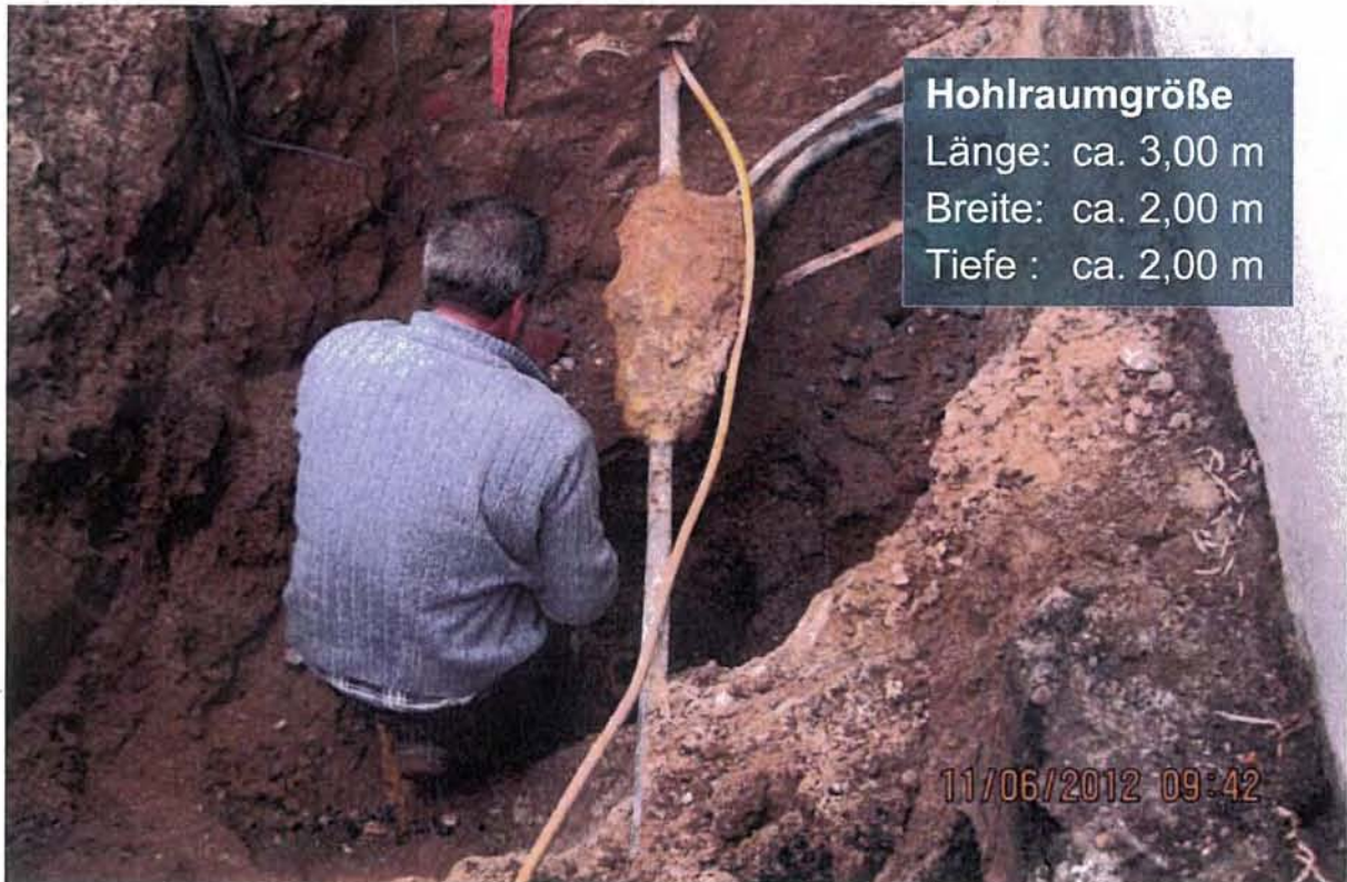
Bild 53: Freigelegter Hohlraum in der Friesenstraße [Foto: Technische Betriebe Solingen]
