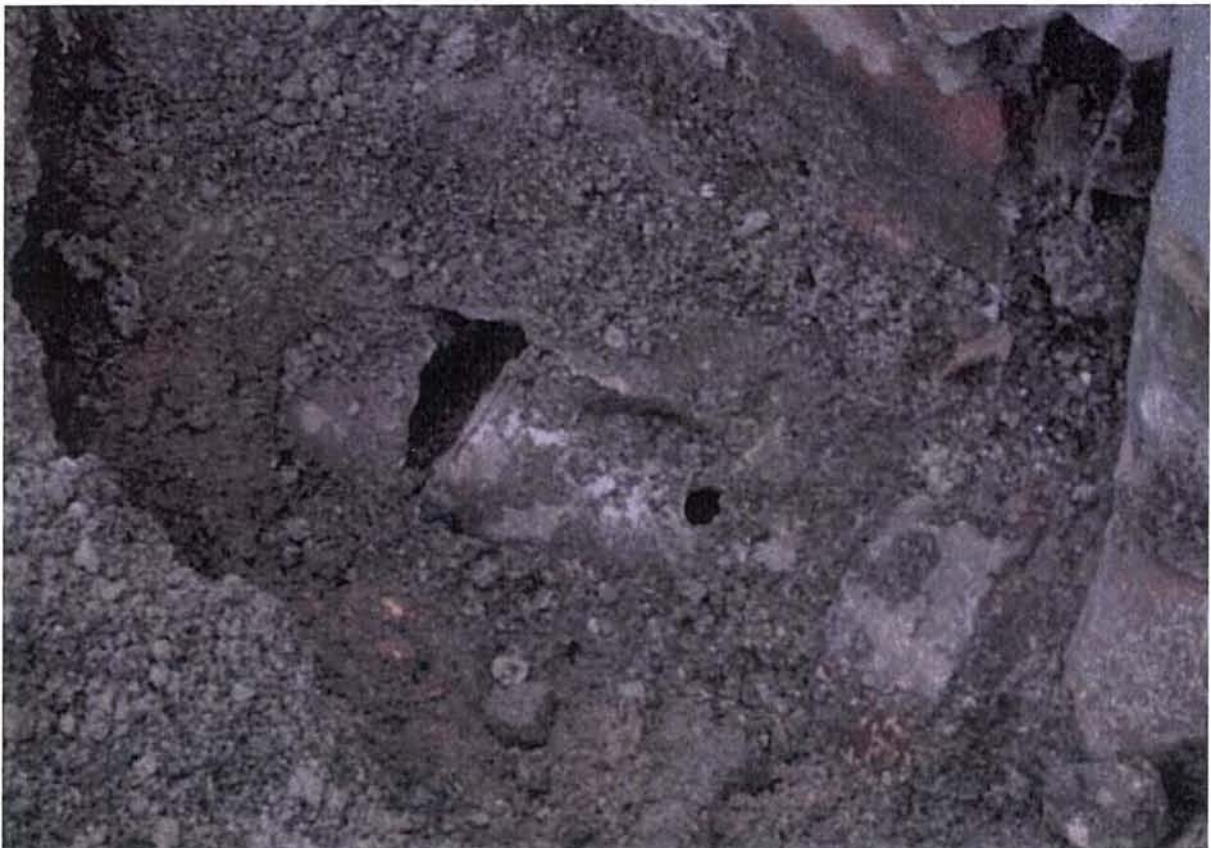
Bild 21: Hohlraum – Detailansicht zu Bild 19 [Foto: Stadt Emmerich]
