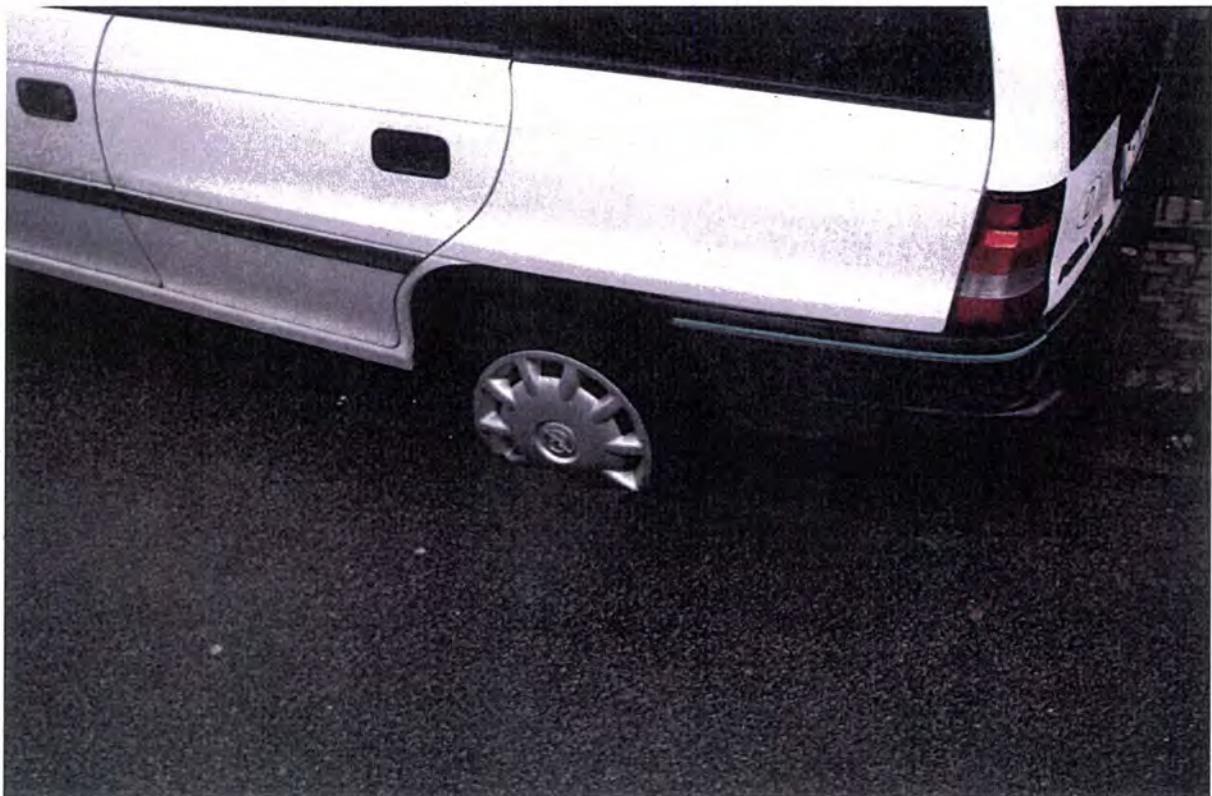
Bild 40: Straßeneinbruch im öffentlichen Verkehrsraum mit „tiefergelegtem“ Kraftfahrzeug (Modell: Opel Astra), Foto 1 [Foto: Stadt Hamm]
