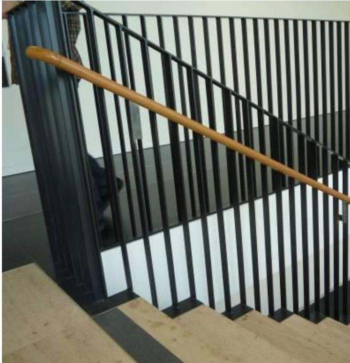
Abbildung eines Geländers mit einer Absturzsicherung in etwa 1,05 m Höhe. Entsprechend den Richtlinien für Barrierefreiheit ist ein Handlauf in 85 cm Höhe erforderlich, der innen am Geländer befestigt ist.
