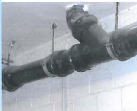
Abhängen der Leitungen unter der Kellerdecke
